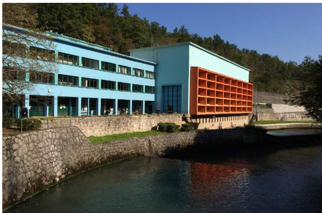
Slika 9.1 Vanjski izgled zgrade HE Gojak
